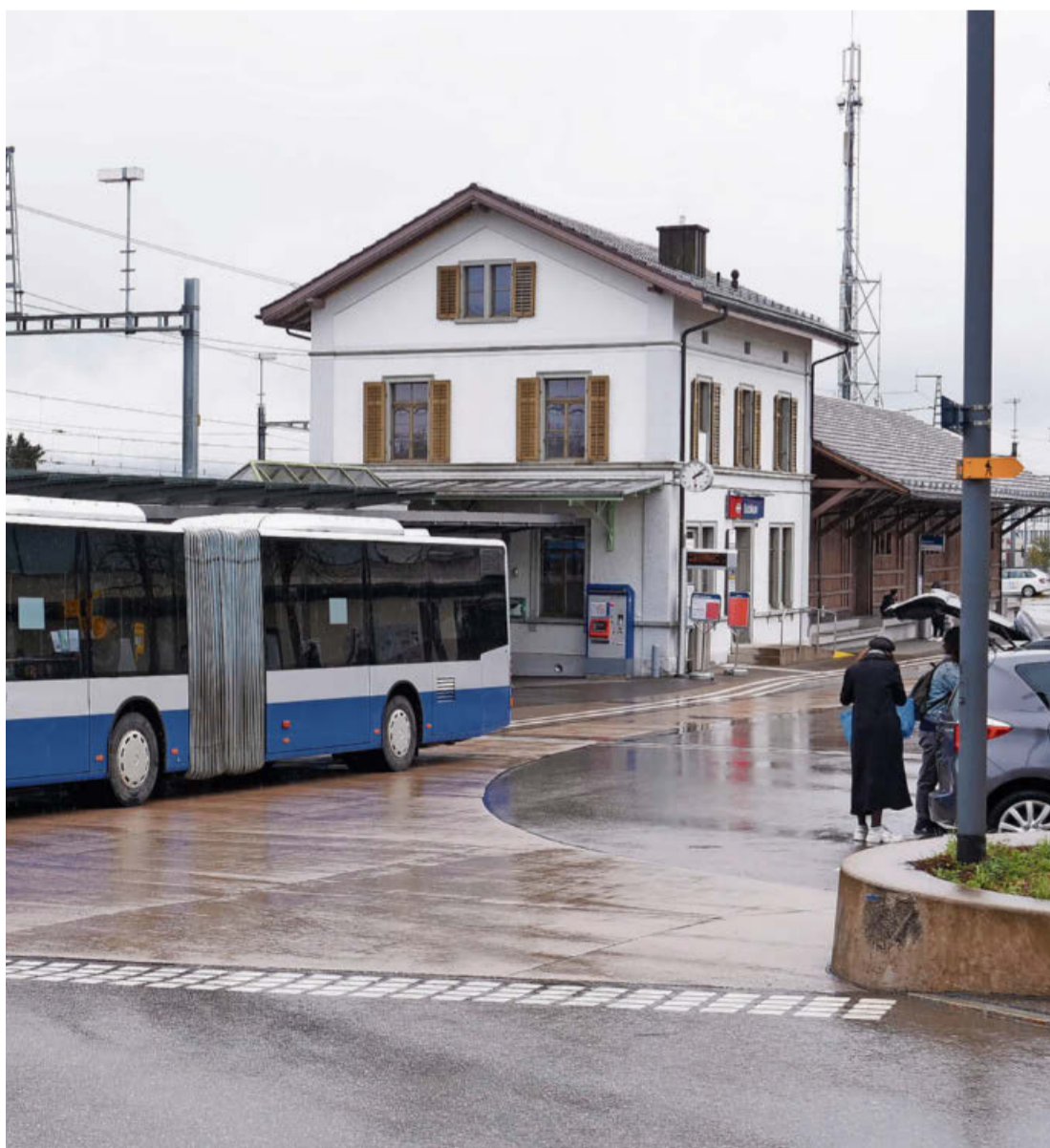
Aktuell steht das Stationsgebäude leer – doch das soll sich ändern.
